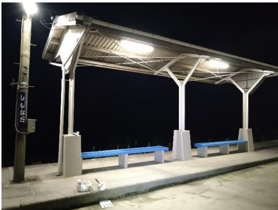
照明制御装置を導入している下灘駅
